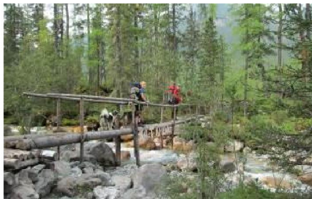
Фото 21. Мостик через р. Шумак.
